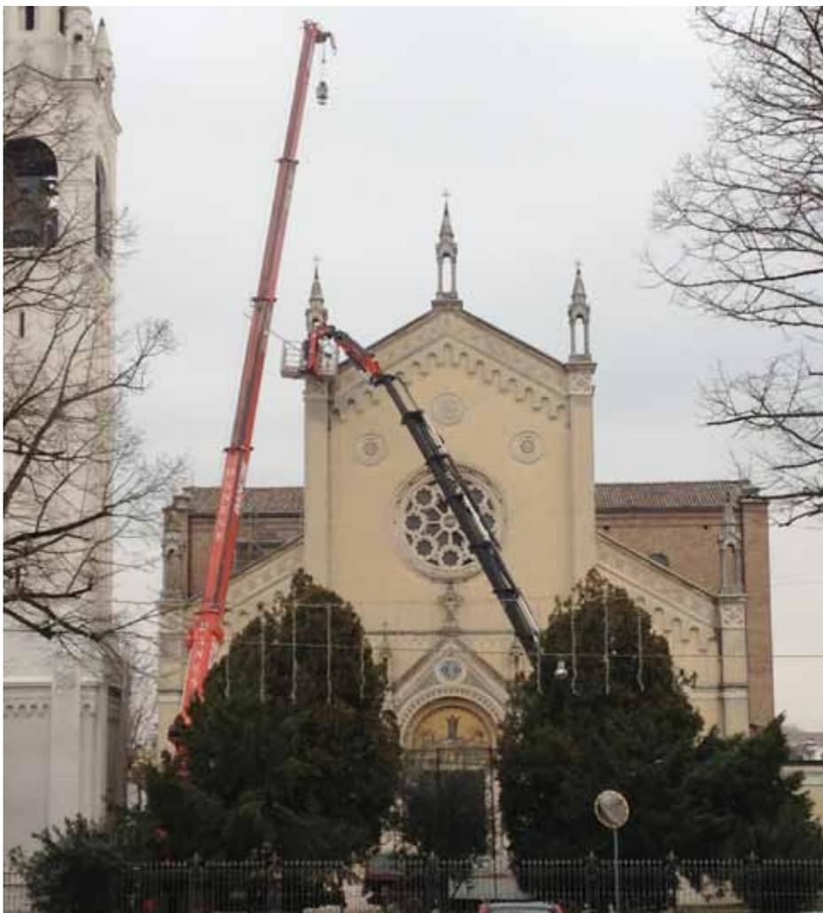
Vista d'insieme della Chiesa, durante l'operazione di rimozione dei pennacoli, pericolanti a seguito del sisma.
