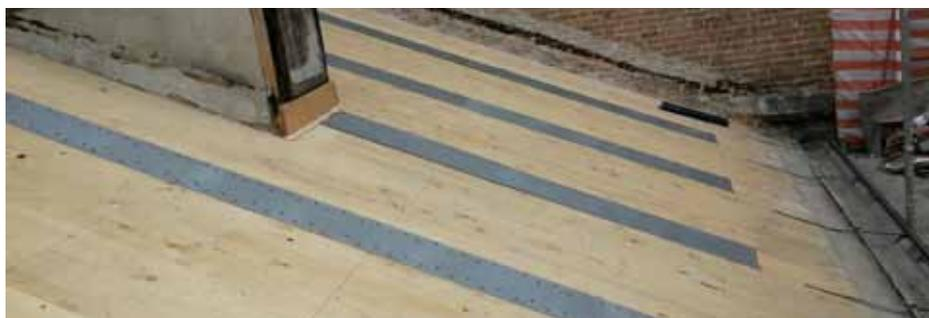
Ricostruzione copertura navate laterali con pannelli x-lam e fasce in acciaio.
