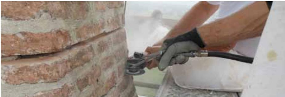
Scanificazione dei letti di malta tramite fresatura meccanica
