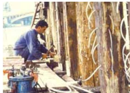
Consolidamento delle quattro pile in legno del Ponte Vecchio detto Ponte degli Alpini opera del 1569 dell'architetto Andrea Palladio. Tutte le pile presentavano notevoli degradi (marcimenti ed erosioni) sia delle strutture verticali fuori acqua (colonne e rostri) sia delle strutture in acqua (soglie e cavazzali). Il consolidamento è avvenuto ricucendo le lesioni con barre in VTR epoxy ed apportando betoncino epossidico nelle zone di maggiore degrado.
