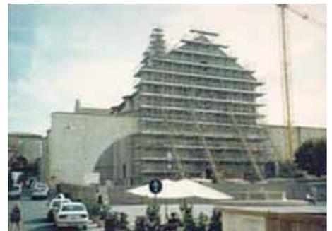
L'intervento di consolidamento della facciata è stato eseguito con cavi armonici inseriti all'interno delle murature. É stato inoltre eseguito il consolidamento delle volte della navata e dell'abside con la realizzazione di una maglia di costolature di bettoncino armato in grado di aumentare la resistenza al sisma delle volte stesse.
